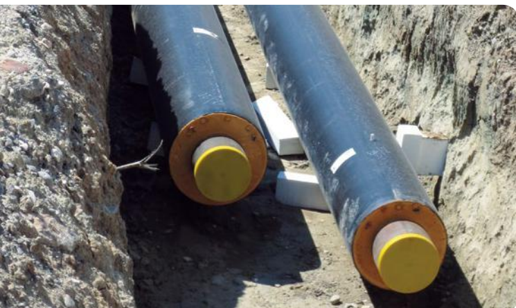
Fernwärmeleitung in Weißenhorn 2018
