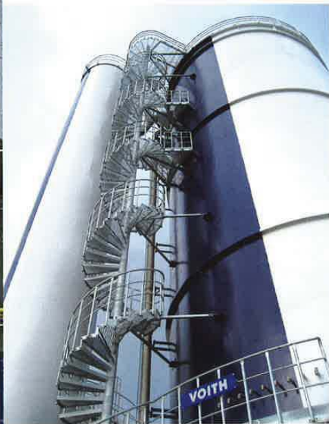
Der Voith-Reaktor zur anaeroben Reinigung von Industrieabwasser ist ein Beispiel für Umwelttechnik in der Papierindustrie.
